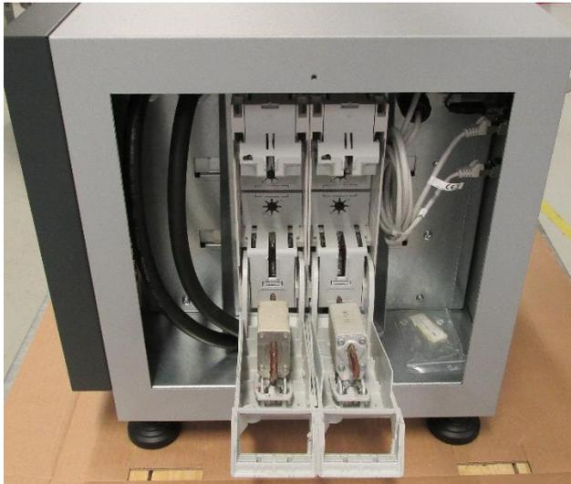
Abbildung 4-13 Batteriespeichersystem, Seitenansicht, Leistungstrenner gezogen
