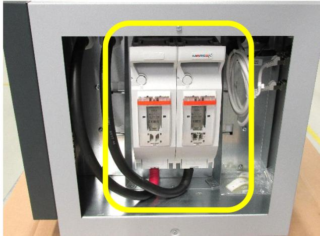
Abbildung 1-2 Batteriespeichersystem, Seitenansicht NH1 Trenner
