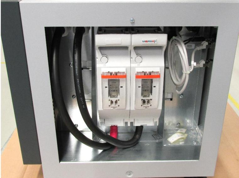
Abbildung 4-7 Batteriespeichersystem, Seitenansicht geöffnetes Gehäuse
